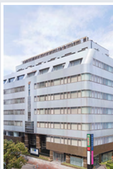
栄センタービル（事務所部分）
