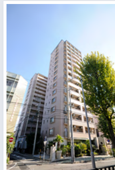
HF 名駅北レジデンス（東棟・西棟）
