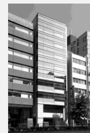
麹町HFビル
