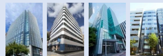
H F 桜通 ビルディング H F 日本橋浜町 ビルディング H F 仙台北町 ビルディング H F 九段南 ビルディング
