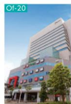
船橋Faceビル
