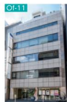
日本橋第一ビル
