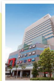
Of-20 船橋Faceビル
