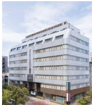
栄センタービル
