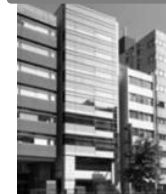
麹町HFビル
