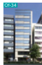
麹町HFビル
