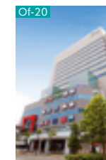
船橋Faceビル
