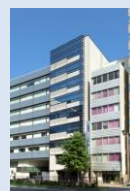
麹町HFビル
