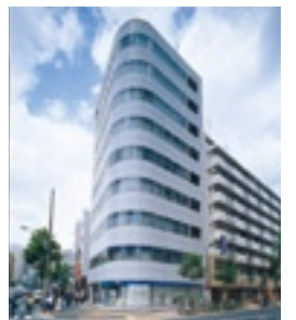
Of-17 八丁堀MFビル
