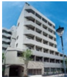
Re-21 アーパイルベルジェ 明大前
