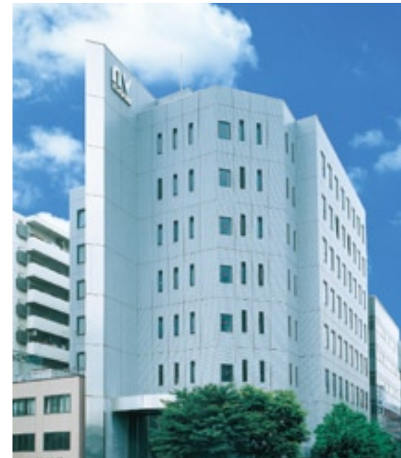
Of-06 NV福岡ビル
