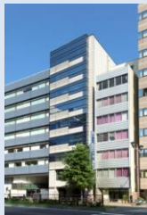
麹町HFビル
