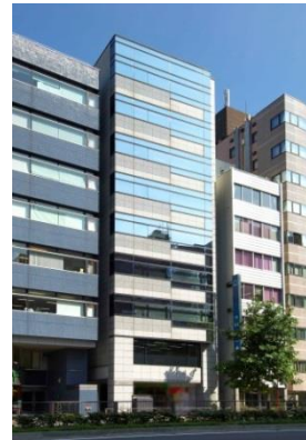
麹町HFビル
