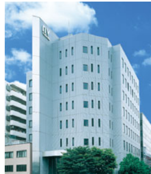
Of-06 NV福岡ビル
