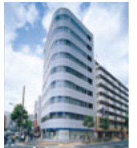
Of-17 八丁堀MFビル
