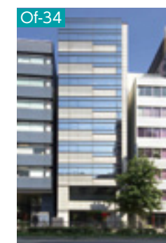
麹町HFビル
