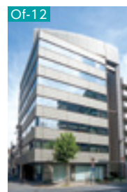
Of-12 HF八丁堀ビルディング
