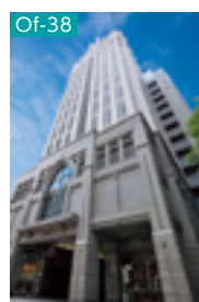
Of-38 アクロス新川ビル
