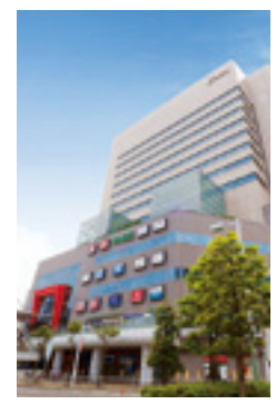
Of-20 船橋Faceビル
