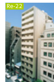
Re-22 HF日本橋レジデンス
