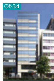
Of-34 麹町HFビル
