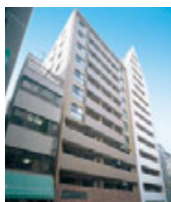
Re-18 エルミタージュ東日本橋
