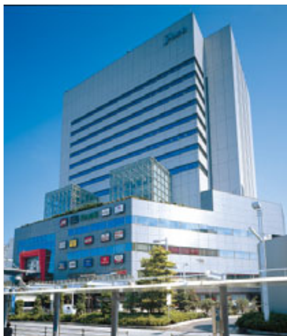
Of-20 船橋Faceビル
