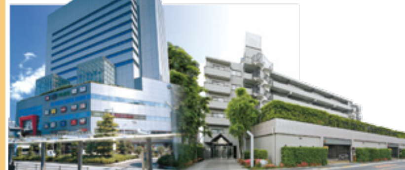
Of-20 船橋Faceビル
