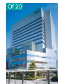
船橋Faceビル
