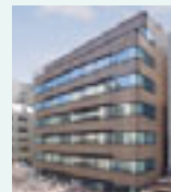
Of-25 茅場町平和ビル
