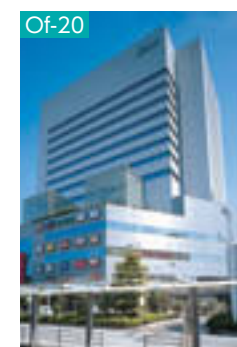
Of-20 船橋Faceビル
