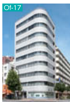
八丁堀MFビル
