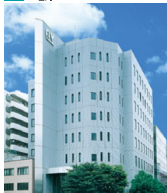
Of-06 NV福岡ビル
